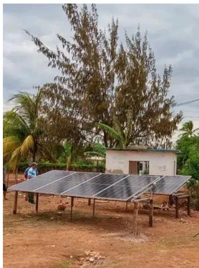
Figura 161. Sistema fotovoltaico, de la Estación de bombeo, del poblado de segundo orden, Pozo Blanco.
