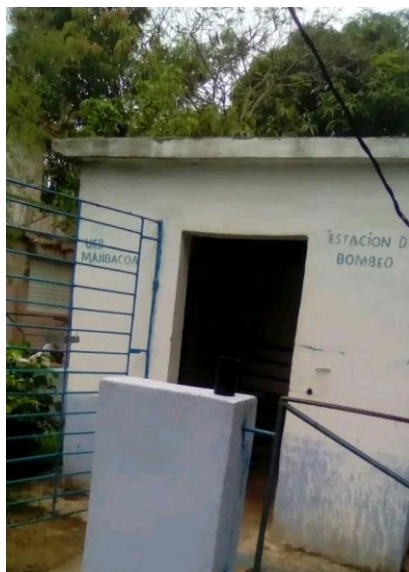
Figura 173. Estación de bombeo, del poblado de tercer orden, Sabanilla.
