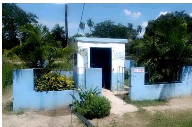
Figura 192. Estación de bombeo, en el Poblado de segundo orden, Yuraguana.
