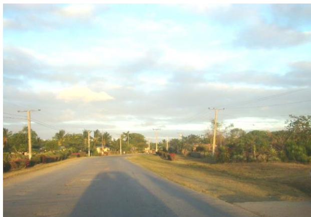
Figura 140. Carretera Las Tunas-Jobabo.
