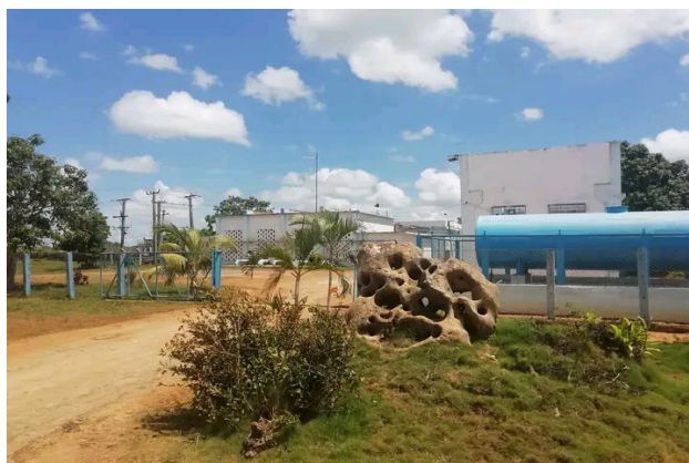
Figura 158. Estación Central del sistema de bombeo de agua, Piedra Hueca.
