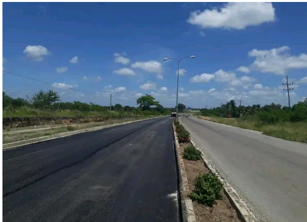
Figura 95. Tramo de la Circunvalación Sur de Las Tunas.
