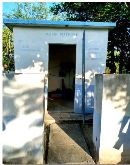
Figura 105. Estación de bombeo de agua, Cruce San Joaquín.
