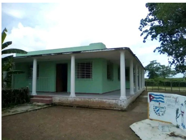
Figura 116. Escuela Primaria del poblado de tercer orden, Entronque Lebanón.
