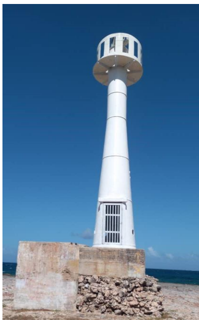
Figura 150. Faro Puerto Padre, en punta Mastelero.
