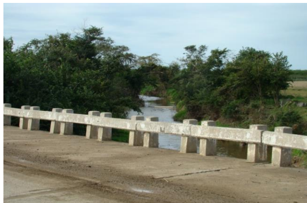
Figura 138. Puente en la carretera Las Tunas-Manatí, sobre el arroyo Laguna de Varona.
