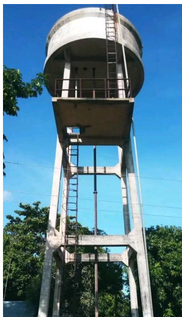
Figura 171. Tanque elevado de la estación de bombeo, Robothán.
